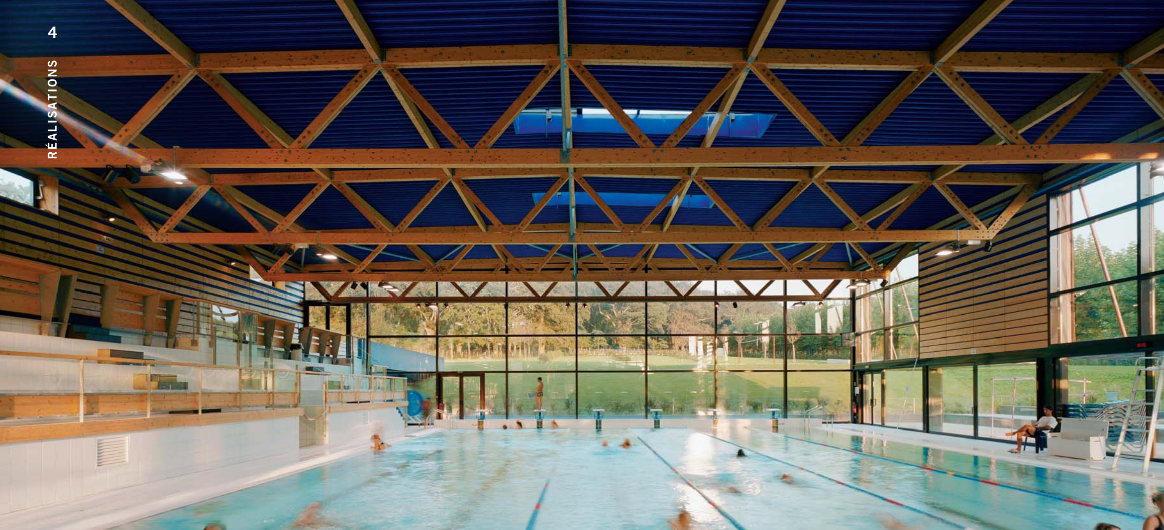
▲ La galerie à mi-hauteur est bordée par une paroi acoustique en planches de résineux non-jointives, recouvrant un absorbant épais sous un voile de PVC.
