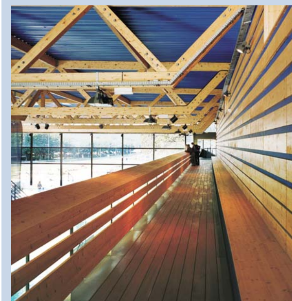
▲ La galerie à mi-hauteur est bordée par une paroi acoustique en planches de résineux non-jointives, recouvrant un absorbant épais sous un voile de PVC.
