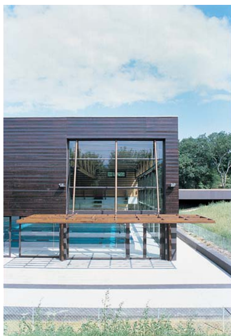
▲ Des brise-soleil ombragent les panneaux vitrés sertis dans la façade en clins de bois foncé.
