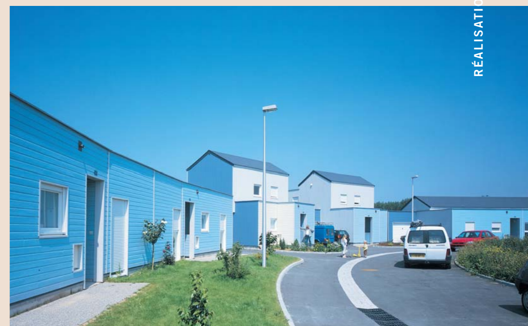
▲ La construction à ossature bois s'adapte parfaitement à la configuration courbe du tracé par le jeu de volumes simplement imbriqués.
