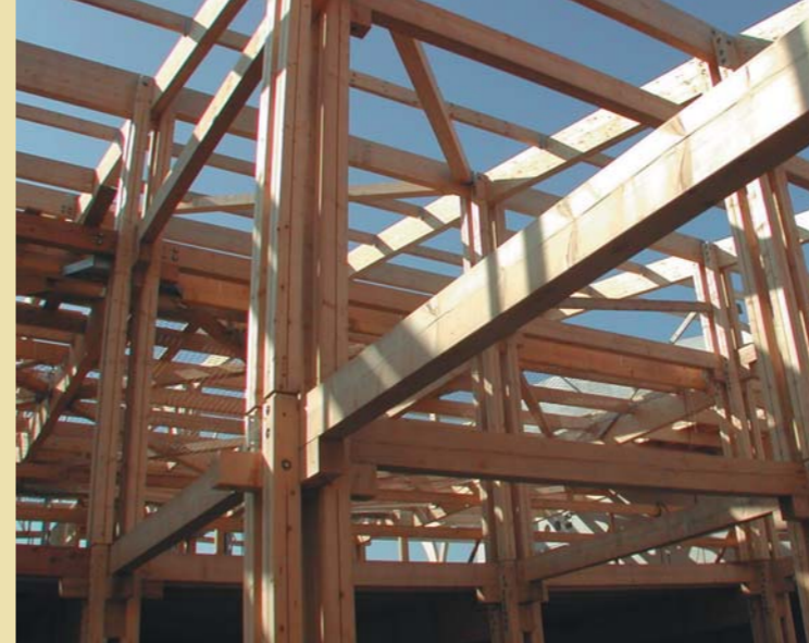
▲ Montage de la structure primaire formée de poteaux quadripartites à l'intérieur desquels filent les poutres horizontales.
