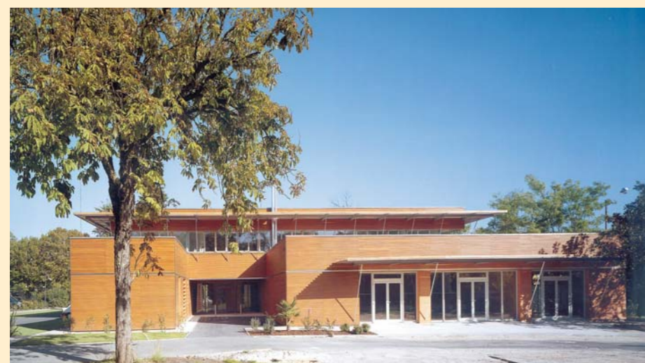
▲ ◀ Le dessin des façades se caractérise par un rez-de-chaussée abrité derrière un bardage en lames de mélèze non jointives et par un étage entièrement vitré souligné par un profond brise-soleil périphérique.
