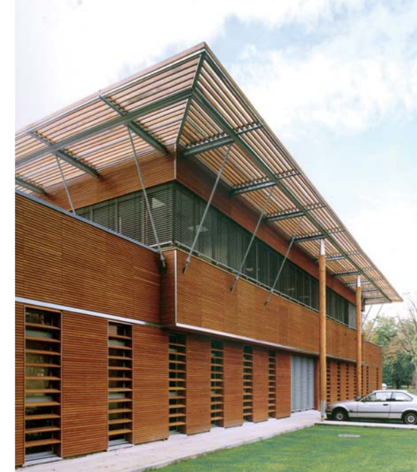
▲ Le brise-soleil est fait de lames de mélèze à claire-voie.
