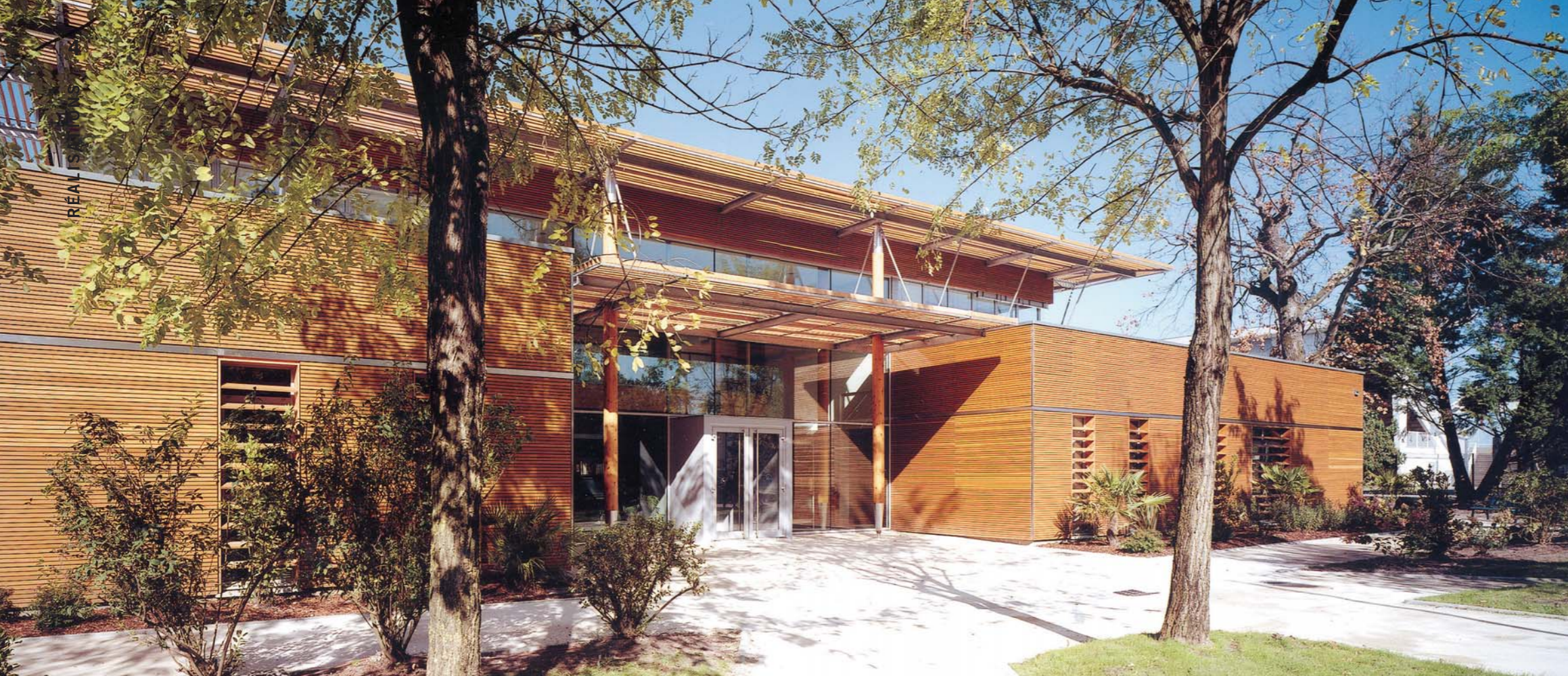
▲ Le brise-soleil est fait de lames de mélèze à claire-voie.
