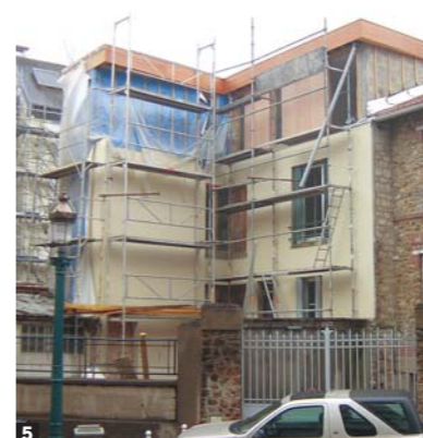
▲ Pose des panneaux de bardage en façade.
