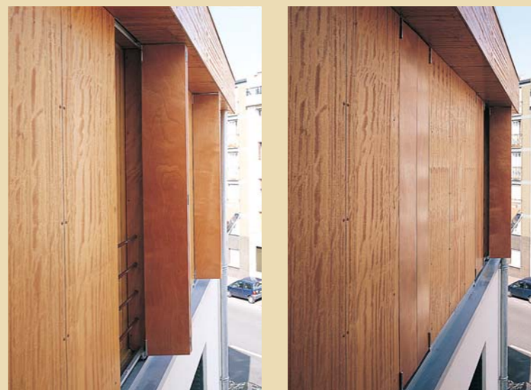
▼ Les volets pliants en position ouverte et fermée.
