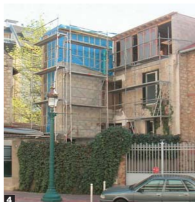
▲ Pose des panneaux de bardage en façade.
