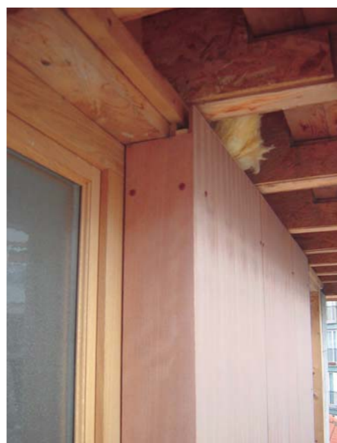
▲ Pose des panneaux de bardage en façade.
